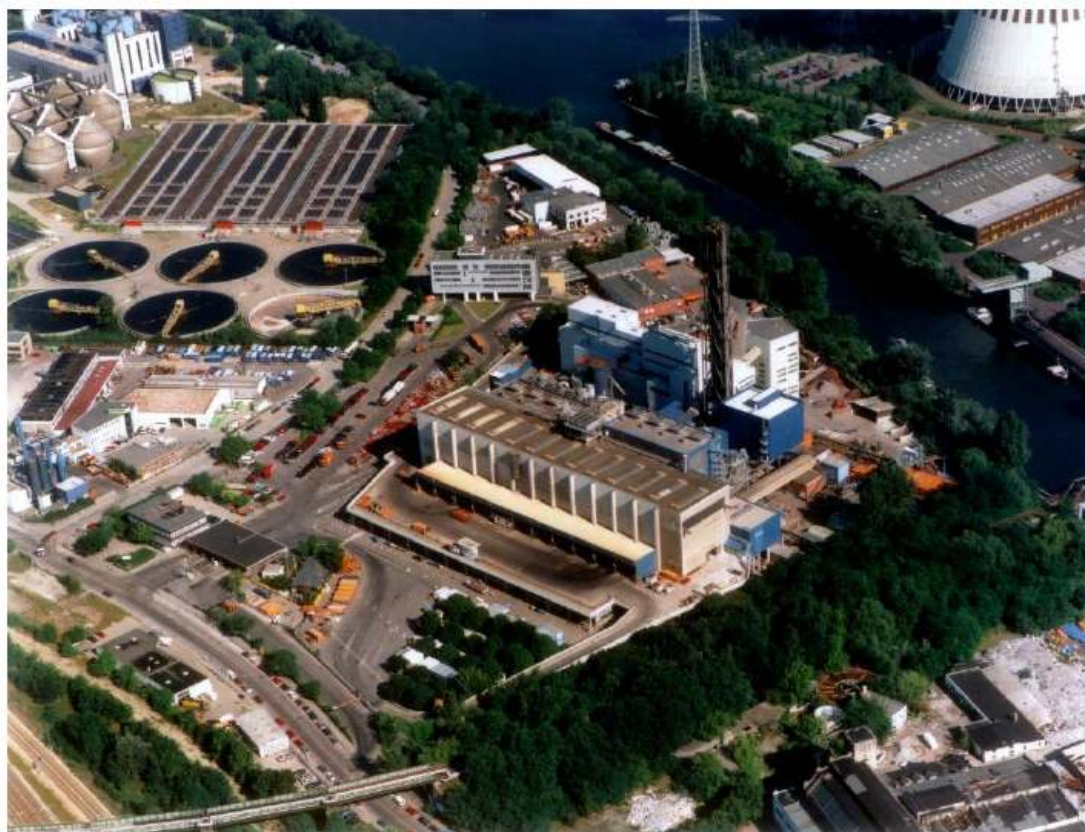
Zdj. 1 MVA Ruhleben wraz z oczyszczalnią ścieków Ruhleben.
