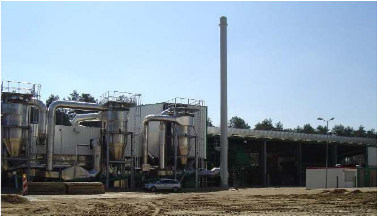
Zdj. 4 MA Köpenick ( mechaniczna przerabialnia z nową suszarnią do produkcji paliwa EBS )
